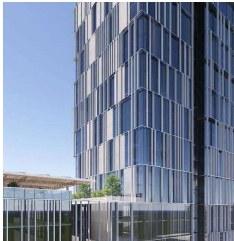
La fachada, construida con piezas modulares, integra un muro cortina cortafuego desarrollado por Aluman.
