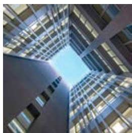
Fachadas sostenibles que mejoran la confortabilidad
